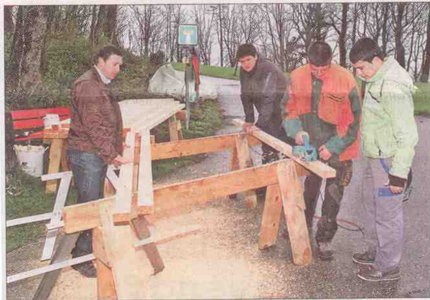
René Hangartner (links) begutachtet die Arbeit der Lernenden, die Bretter für den zukünftigen Tisch zurechthobeln.
